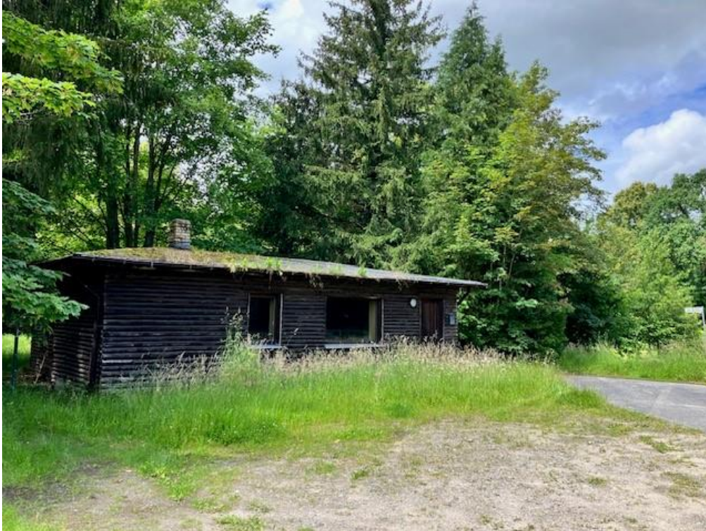
Ansicht von der Landesstraße L 212
