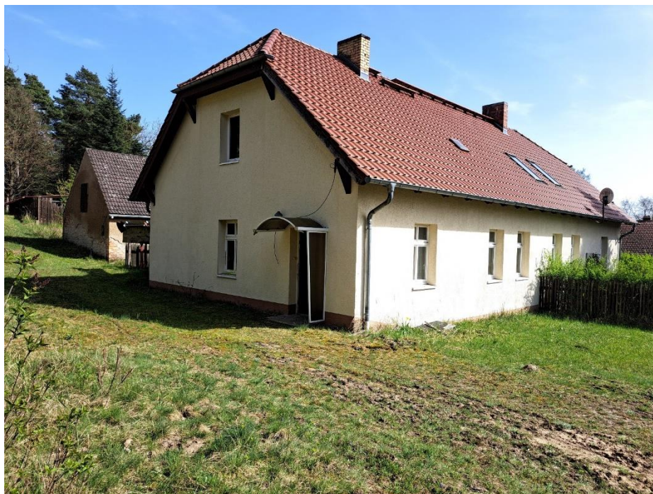
Blick auf den Nordgiebel des Wohnhauses, Eingang Wohnung Diemitzer Schleuse Nr. 2
