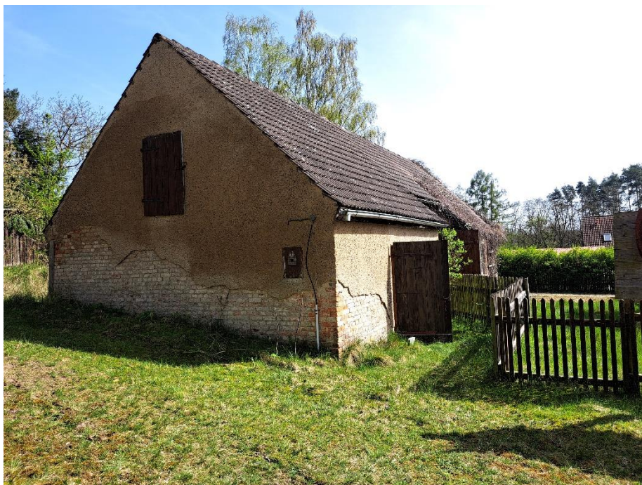
Blick aus nördlicher Richtung auf Nebengebäude 1
