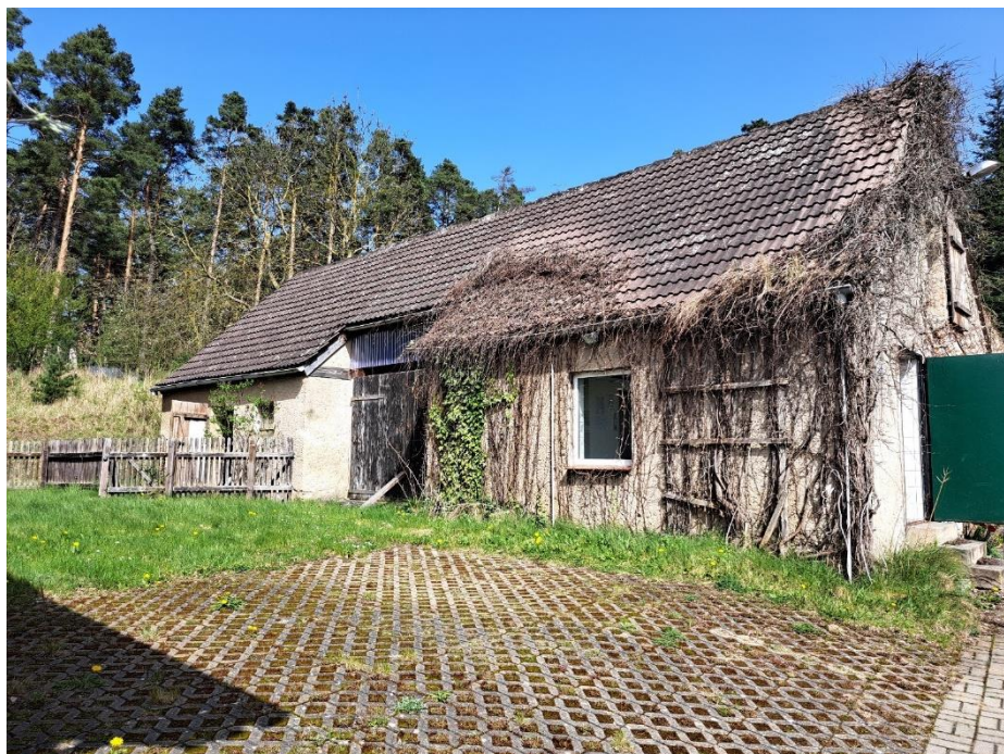
Blick aus südlicher Richtung auf Nebengebäude 1
