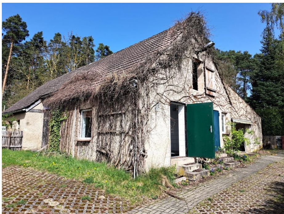
Blick aus südlicher Richtung auf Nebengebäude 1 und Garage
