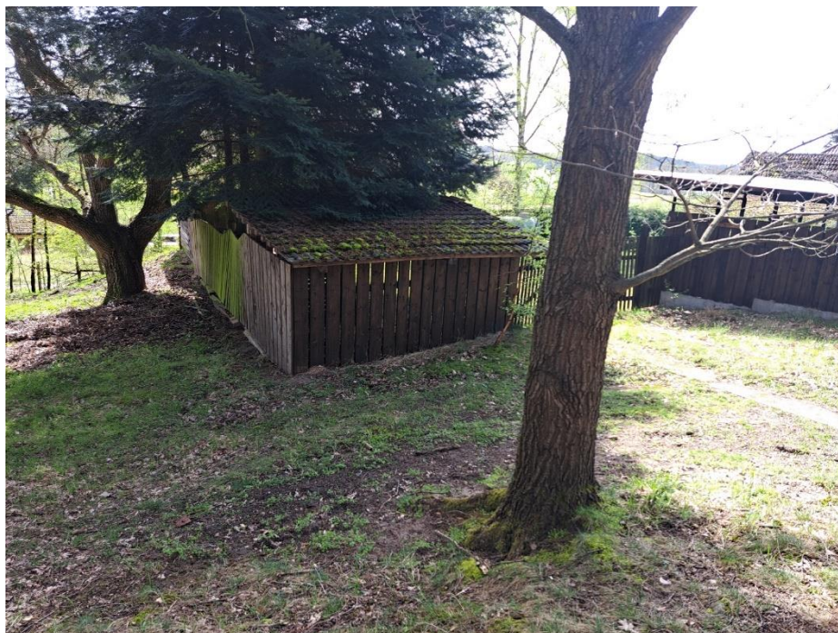
Holzschuppen, Blick aus nördlicher Richtung
