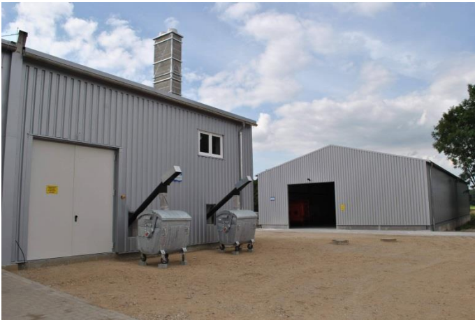
Heizhaus für Strohheizungsanlage und Aschecontainer (Foto LGMV)
