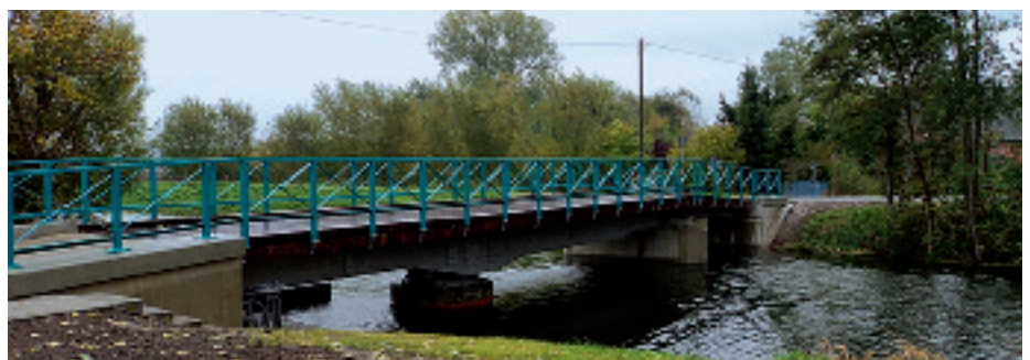
Die Brücke über den Bützow-Güstrow-Kanal bei Zepelin wurde im Rahmen eines Flurbereinigerungsverfahrens erneuert.
